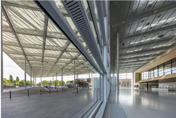
Das Foyer und der Vorplatz der Neuen Messe Süd (Foto: Messe Düsseldorf/Ansgar M. van Treeck)
